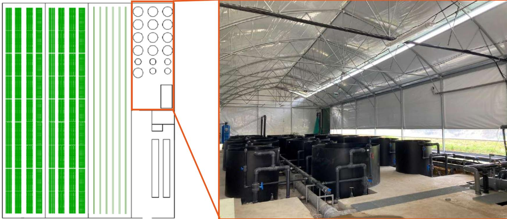
Le système piscicole de 100 m<sup>3</sup> comporte **18 bassins**, un biofiltre de 20 m<sup>3</sup>, un filtre à tambour, un skimmer, un cône d'oxygénation avec générateur d'oxygène, filtre UV, un atelier de transformation, etc ...
